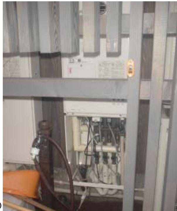
床暖房熱源機 (温水暖房専用ガス熱源機)
