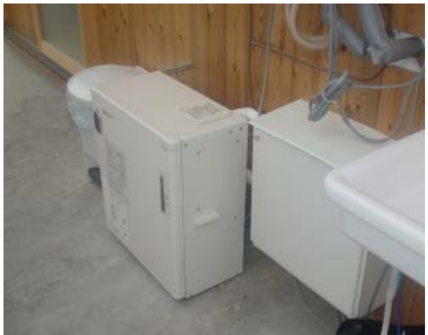
床暖房熱源機 温水暖房専用灯油ボイラ
