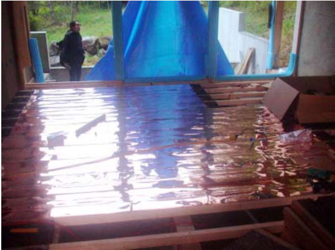
床暖房パネル工事
