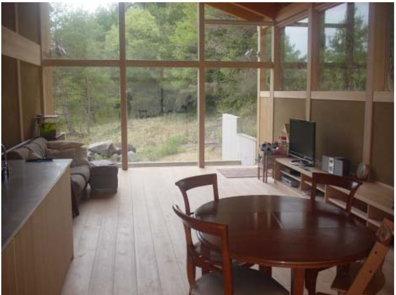
内部完成(仕上げ材: 桧 縁甲板 巾180mm 厚み27mm)
