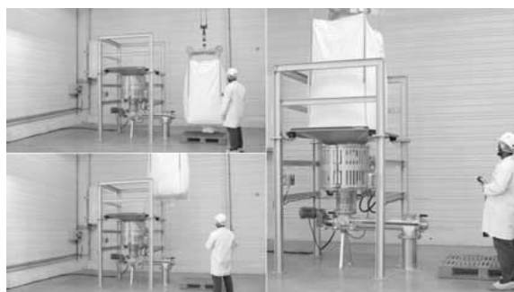
図3 フレコン設置
