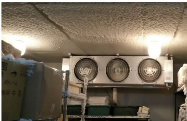
Fig. 2 TKSシステム稼働前の庫内写真
