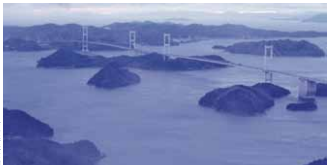
来島海峡大橋
